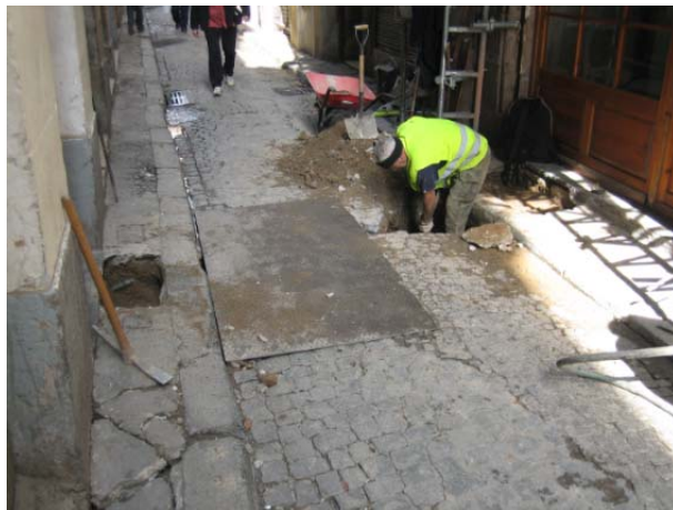
FOTO 1. Vista General. Carrer d'En Robador
